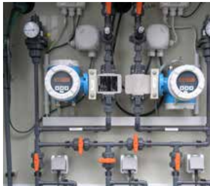
Installation compacte d'analyseurs d'orthophosphate et de phosphore total CA80PH / CA80TP dans le conteneur (ci-dessus)
