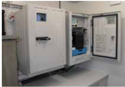
Installation compacte d'analyseurs d'orthophosphate et de phosphore total CA80PH / CA80TP dans le conteneur (ci-dessus)
