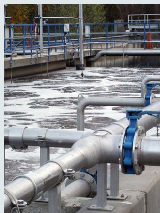
空気 (O 2 ) - 活性汚泥槽の曝気 (下水処理場)
