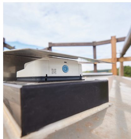
Cloudbasierter Füllstandsensor Micropilot FWR30, auf dem Salzsilo montiert.
