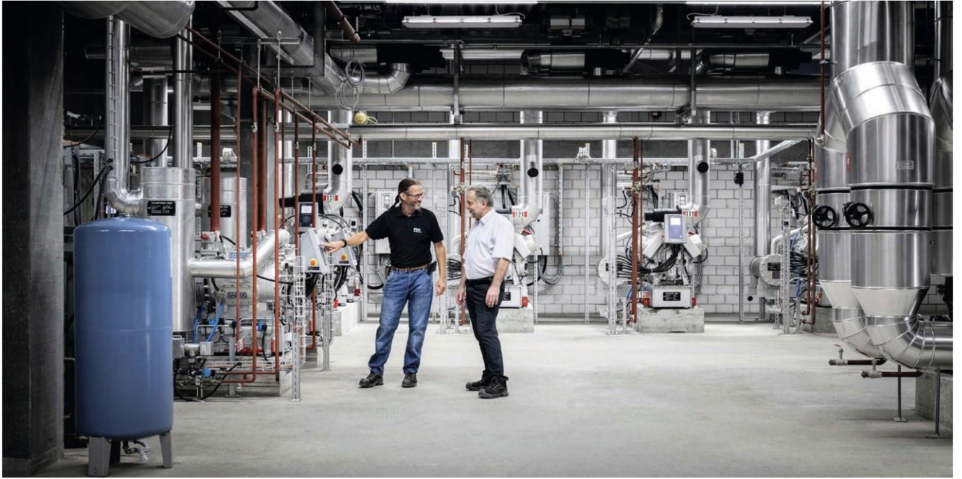
경기장 지하에 있는 에너지 센터 내부 모습. 아이스 링크의 냉기, 실내 공기 제습을 위한 공조 냉기, 주변 사무실 건물의 냉기가 바로 이곳에서 생성됩니다.
