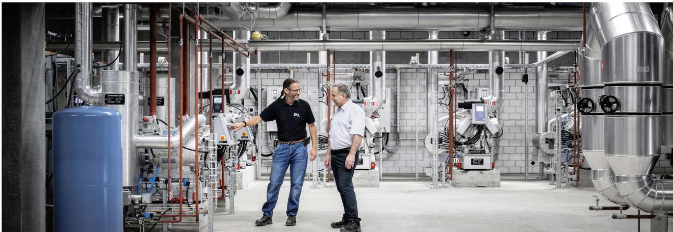
Vista del centro de energía en el sótano de el estadio. Aquí, la refrigeración para la pista de hielo, el aire acondicionado frío para deshumidificar el aire ambiente y el aire frío para los edificios de oficinas circundantes son generados.
