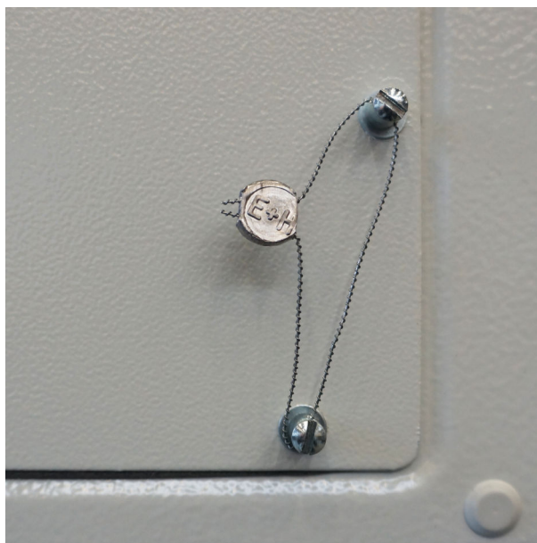
図 27 シールワイヤで封止されたネジ
