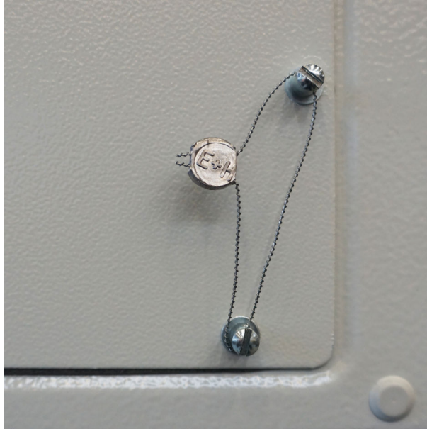
图 27 使用封锁线锁死螺丝
