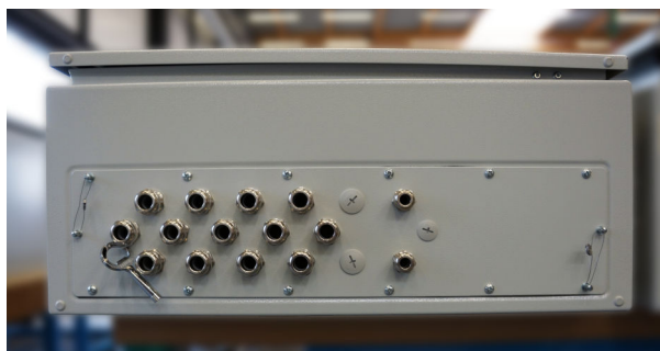
Fig. 26 Localização das entradas para cabos
