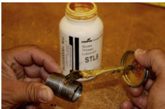
Figura 25. Aplicación de lubricante en las roscas
