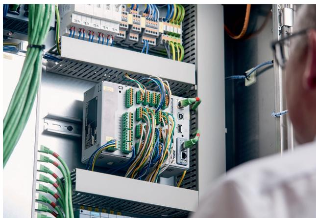
Industry 4.0が組み込まれたスイッチキャビネット: Memograph MはWebサーバーを内蔵しており、オペレータはリモートアクセスによって保存データの呼び出しや機器パラメータの設定を行うことができます。
