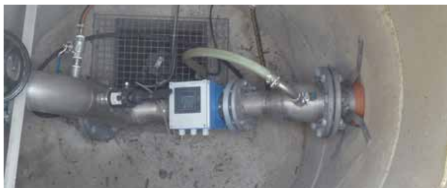
Prélèvement des eaux usées dans un puits
