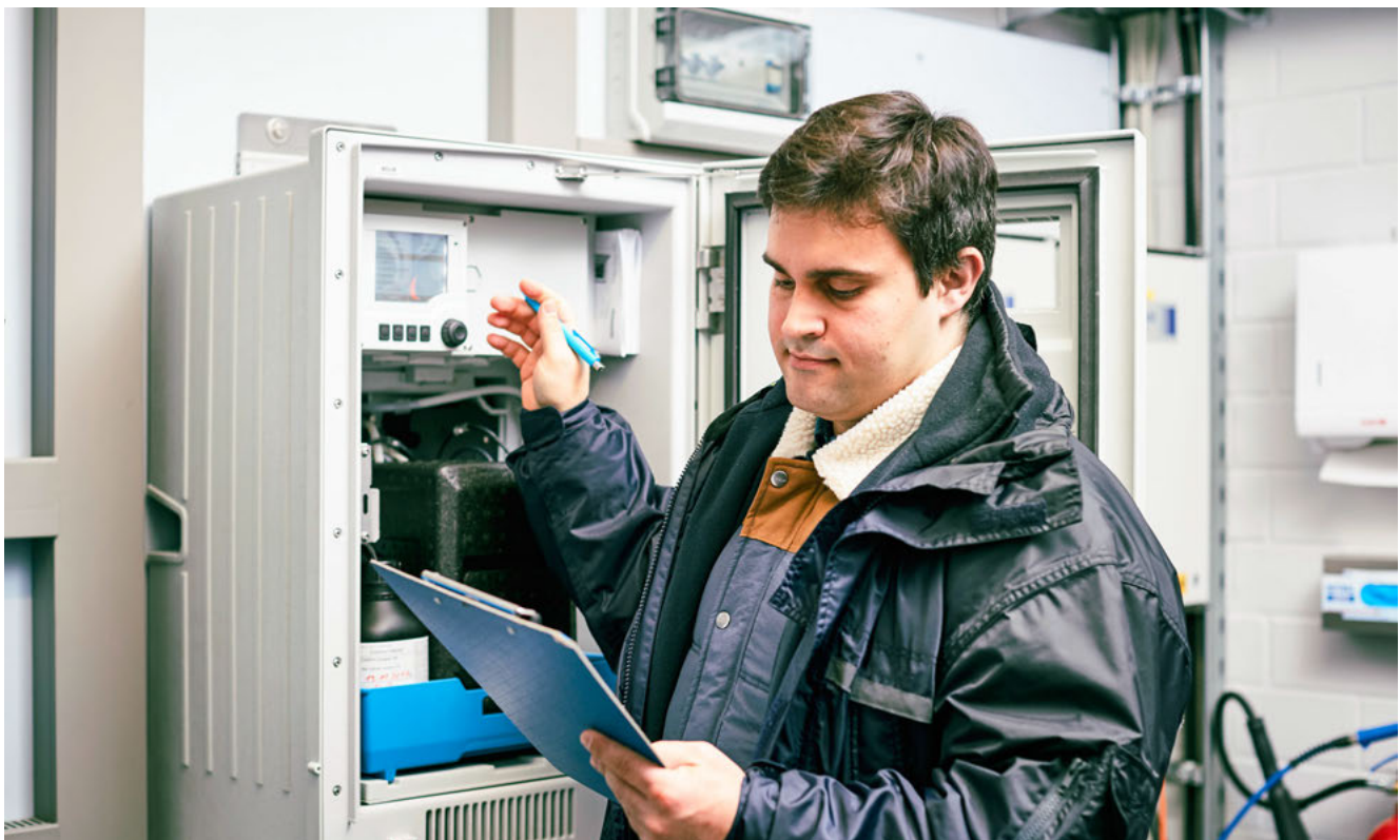
Der Orthophosphat-Analysator Liquiline System CA80PH liefert reproduzierbare Messwerte für eine zuverlässige Fällmitteldosierung.
