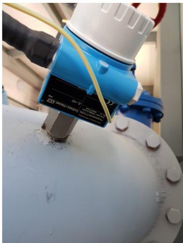
Распознавание предельного уровня и защита насоса от эксплуатации всухую благодаря компактному зонду FTW360.
