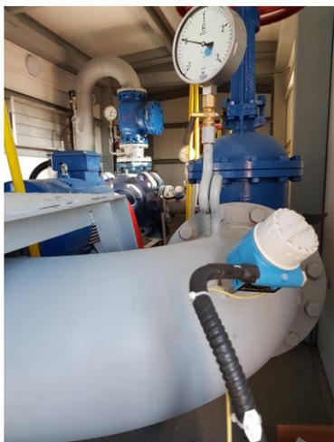
Преобразователь давления Cerabar M PMC51 обеспечивает высокую степень безопасности благодаря керамической мембране, устойчивой к вакууму, со встроенным обнаружением повреждений.
