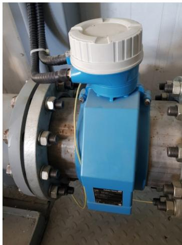
Энергосберегающее измерение расхода без потерь давления благодаря однопроходной конструкции сенсора. PROMAG L 400 также сокращает затраты на установку благодаря полнопроходной конструкции сенсора.
