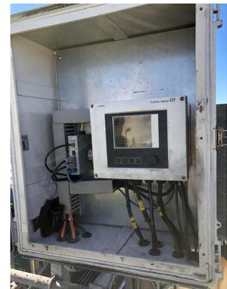
Eine Messstelle besteht aus einem Sauerstoff-Sensor Memosens COS81D, einem pH-Sensor CPS11D und einem Liquiline CM44 Messumformer.
