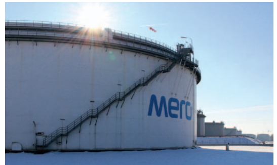
Tanklager der Mero in Vohburg an der Donau
