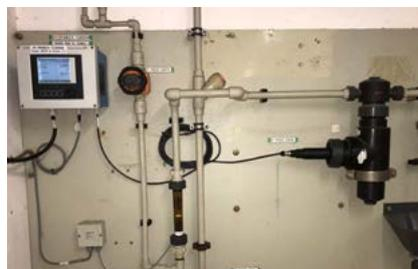
Messstation mit Messumformer Liquiline CM442 und Trübungssensor Turbimax CUS52D
