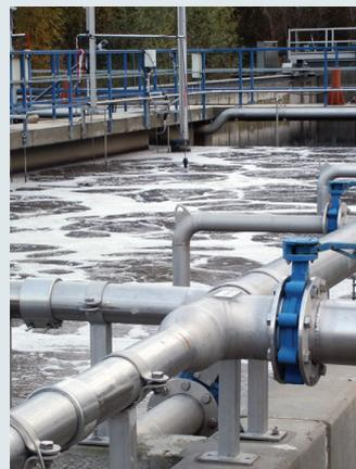
Aria (O<sub>2</sub>) – aerazione delle vasche di fanghi attivi (impianti di trattamento delle acque reflue)
