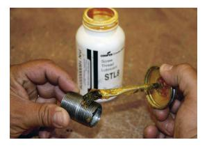
Figure 3-4 Applying conduit lubricant
