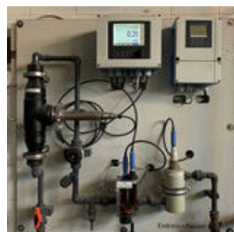
Analysepanel zur Messung des freien Chlors am Ende des Trinkwasseraufbereitungsprozess
