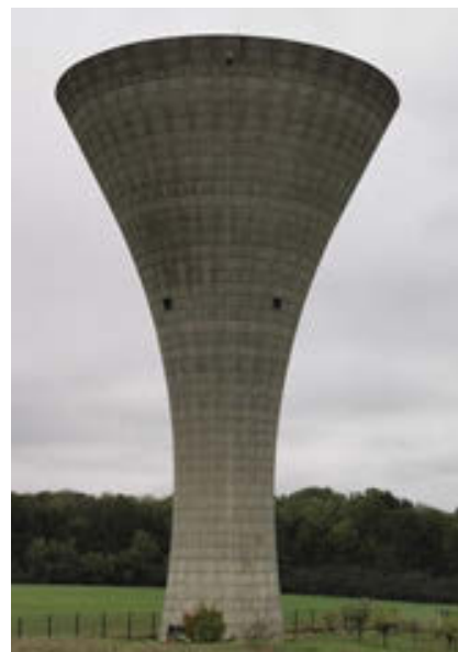
Trinkwasserspeicher in Redlach (900m3)
