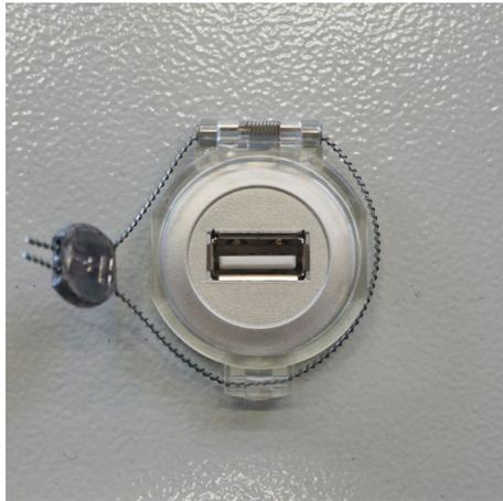
29 Port USB scellé avec un fil d'étanchéité
