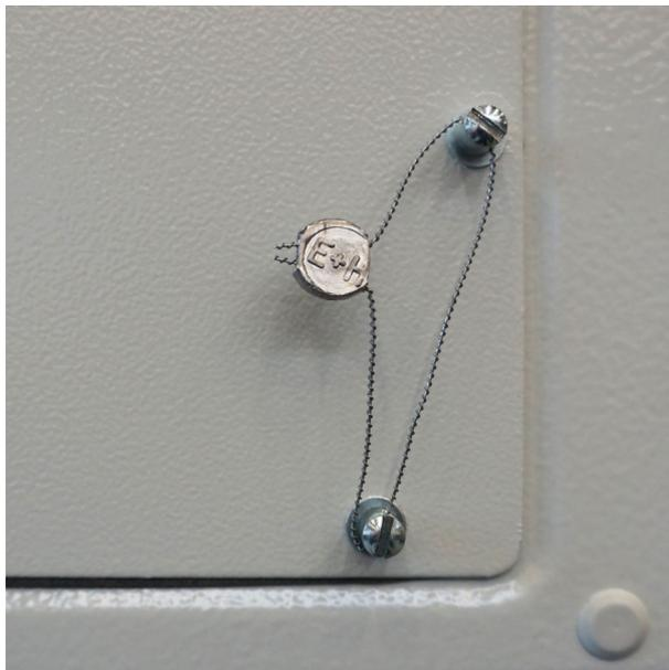
▣ 27 *Vis scellées avec un fil d'étanchéité*
