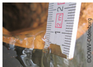
Manuelle Messung der Belagsdicke
