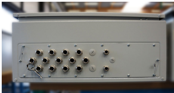
26 Position der Kabeleinführungen
