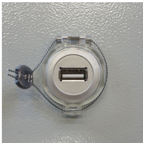
29 Vrata USB, zapečateni s pečatno žico
