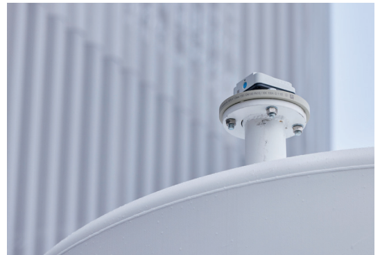
Sensor auf den Silos: Füllstandsmessgerät Micropilot FWR30 (batteriebetrieben)
