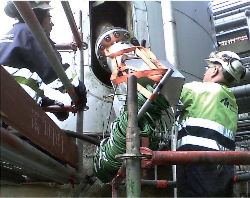
Die iTHERM MultiSens Multipoint-Baugruppe mit 27 unabhängigen Thermoelementsensoren ermöglicht eine genaue Erstellung des Temperaturprofils im Reaktor.
