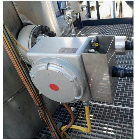
iTHERM MultiSens Multipoint-Temperaturbaugruppen sind mit einer einzigartigen innovativen Diagnosekammer erhältlich, die zusätzliche Sicherheit und wertvolle Prozessinformationen für eine vorausschauende Wartung bietet. Die Diagnosekammern dämmen nicht
