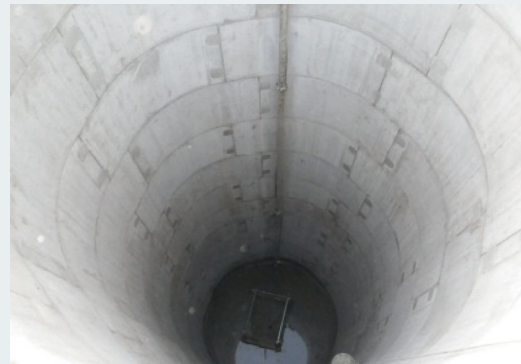
断熱壁2： 断熱壁1の外側、地下部は縦杭 それぞれの断熱壁内部を強制循環
