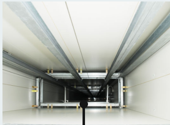
断熱壁1：水槽エレベーターの周辺
