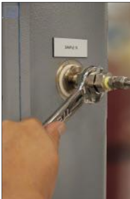
Fig 47. Remoção do corta-chamas
