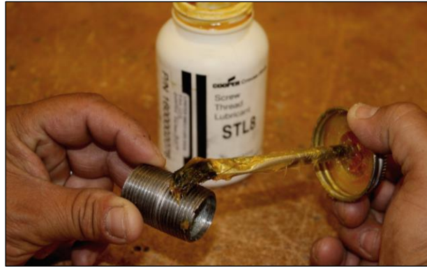
Fig 21. Aplicação de lubrificante para condutas
