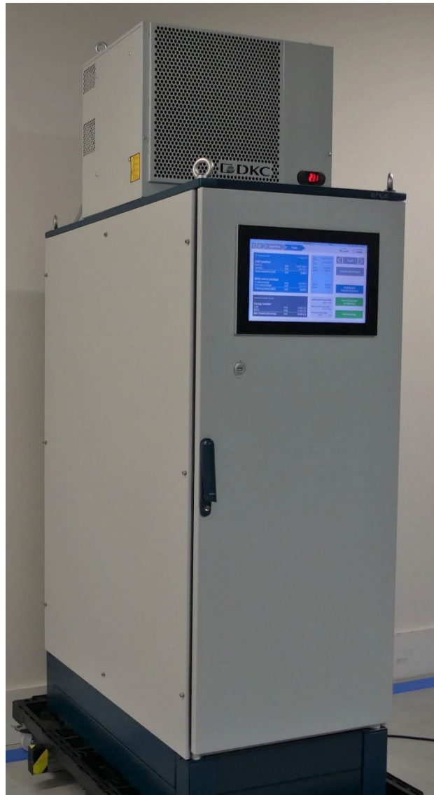
LNG Metering Computer installed a cabinet.
