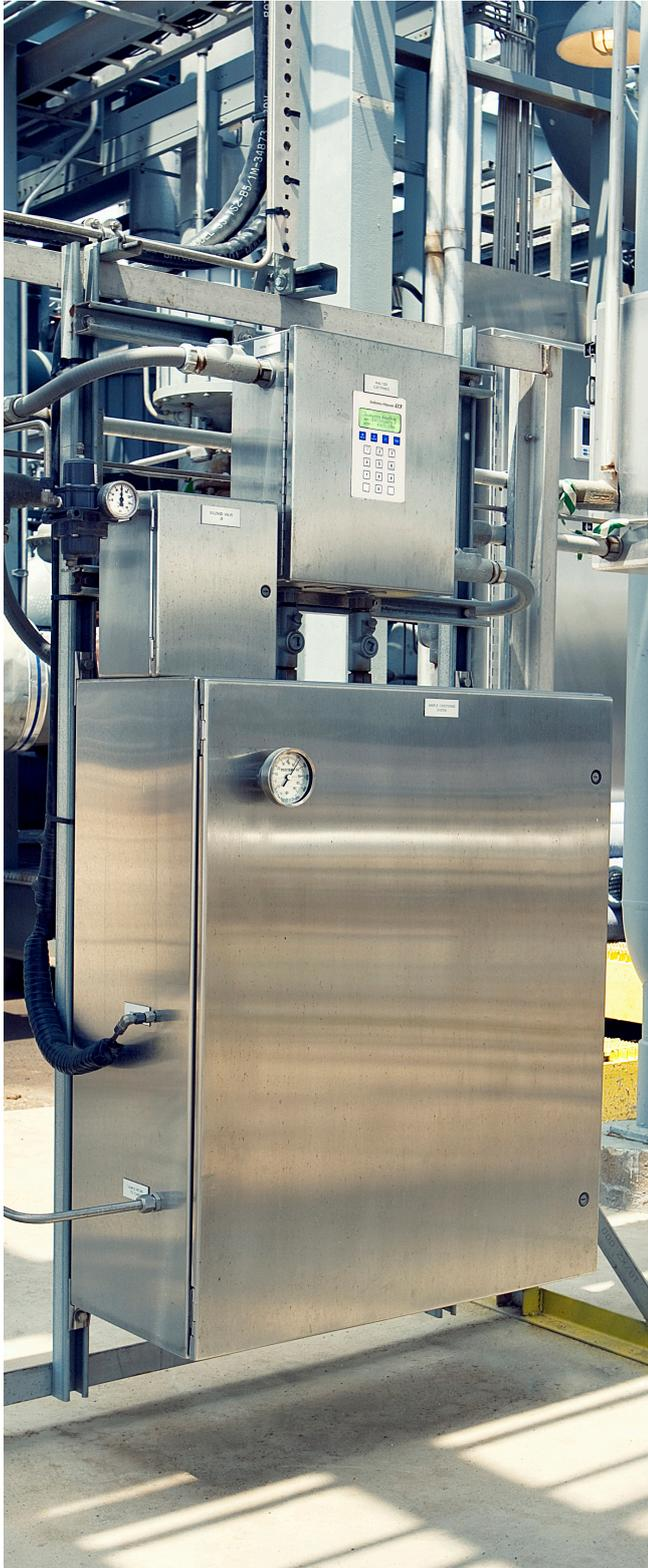
Endress+HauserのTDLASアナライザは、天然ガス中の不純物をサブppmレベルから低パーセントレベルまで、オンラインでリアルタイムに測定します。Endress+HauserのTDLASアナライザには、LNG生産用の天然ガス供給における $\text{H}_2\text{O}$ 、 $\text{H}_2\text{S}$ 、 $\text{CO}_2$ の監視において、他の技術に比べて大きな利点があります。
