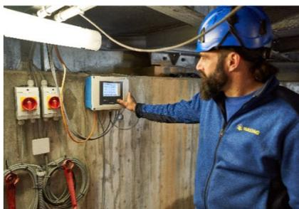
Surveillance du déversement des eaux usées non polluées dans le ruisseau, conformément à la protection des eaux.
