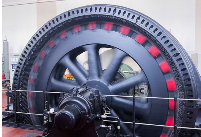
Generatoreinheit eines Wasserkraftwerks
