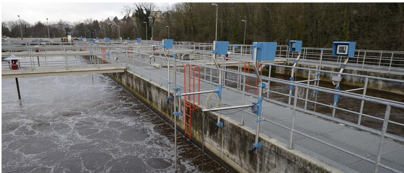
Bassin d'aération d'une station d'épuration municipale avec analyse en ligne
