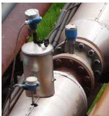
Système typique de mesure de la vapeur composé d'un débitmètre vortex, d'un capteur de pression et d'un capteur de température.
