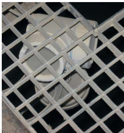
Para reducir el riesgo de caída el Micropilot FMR56 se por debajo de la pasarela
