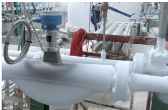
Mesure précise du débit même à -183 °C : le Promass F mesure l'oxygène liquide à Salzgitter
