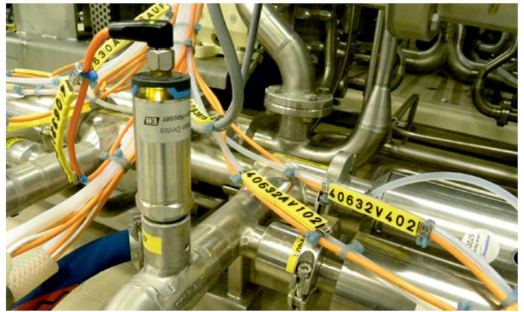
Le Liquipoint FTW33 sur une canalisation de faible diamètre à la laiterie Müller
