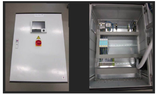
Armoire électrique et enregistreur de données
